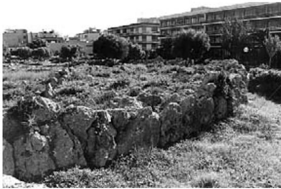
Teil der Umfassungsmauer im westlichen Bereich der Anlage.
